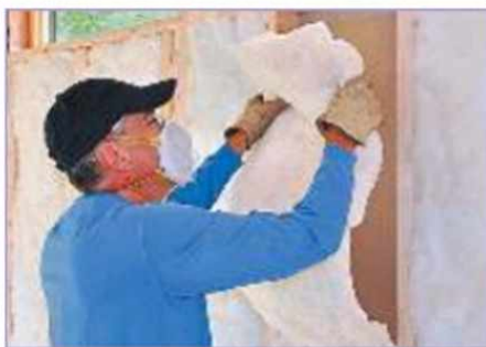
Рис. 9.13. Уменьшение потерь тепловой энергии — утепление стен домов
