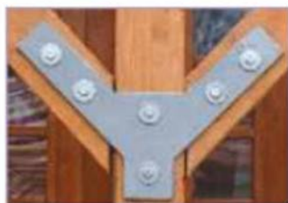
Рис. 6.4. Крепление деталей из древесины на болтах
