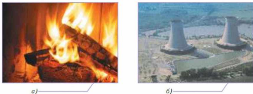
Рис. 9.4. Первичная тепловая энергия горящей древесины (а); вторичная тепловая энергия, выделяемая градирнями (б) — сооружениями для охлаждения воды атмосферным воздухом
